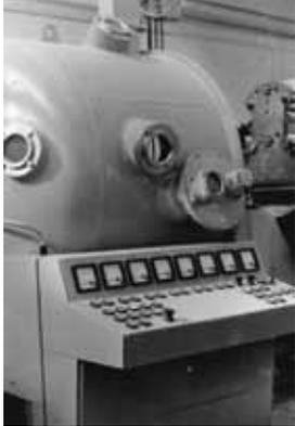
Die erste vom Ardenne-Institut konstruierte Bedampfungsanlage FOBA 500/1 konnte Dielektrika bis zu einer Breite von 500mm metallisieren.
